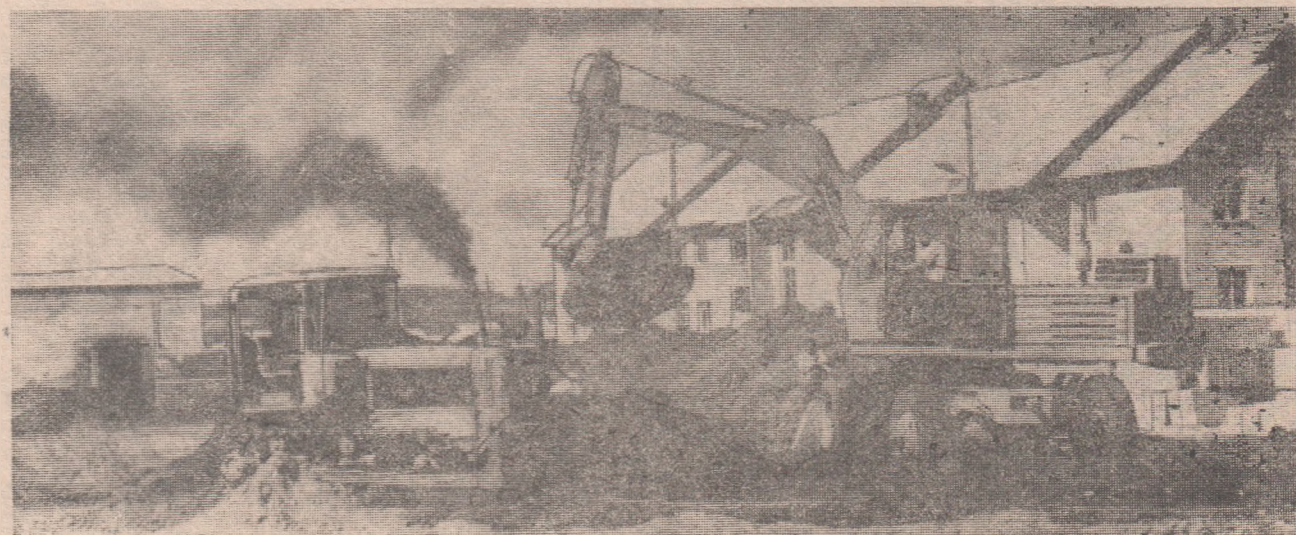
Так, с земляных работ, начинается строительство нового 12-квартирного дома в микрорайоне жилого квартала райцентра. Пока здесь готовится котлован, но вскоре появится фундамент — основа нового дома, и это только начало. Ведут строительство здесь прораб М. Соколов и мастер А. Богатырев. Это будет четвертый по счету жилой 12-квартирный дом.
